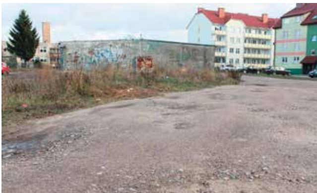
Odcinek, który ma być remontowany
