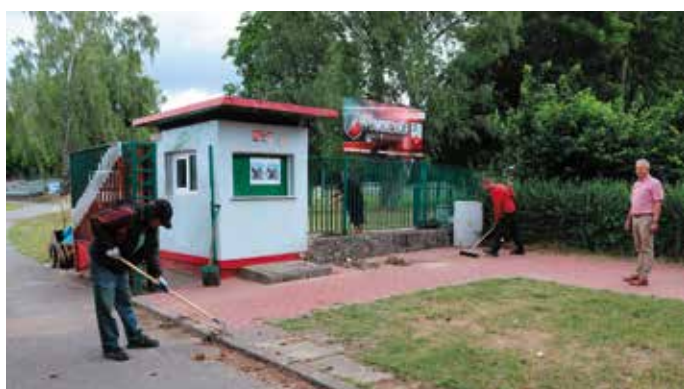
Trwają prace na stadionie miejskim
